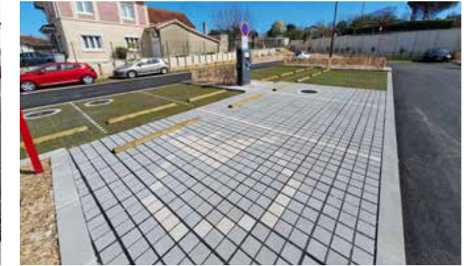
STATIONNEMENT PAVÉS - Place PMR
