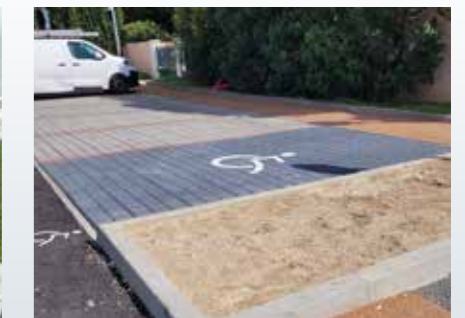
STATIONNEMENT PAVÉS Place PMR
